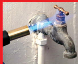
Dégel de canalisations
